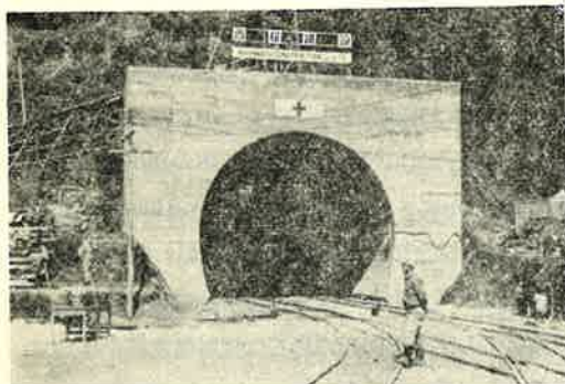
写真-1 北陸トンネル敦賀口門
