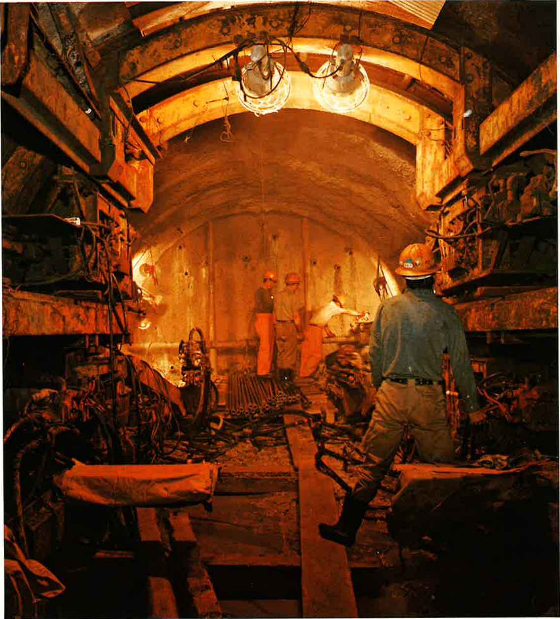
青函建設局電飛工区先進導坑切羽注入作業状況
