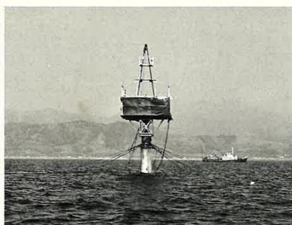
吉岡沖海底ボーリング現場
