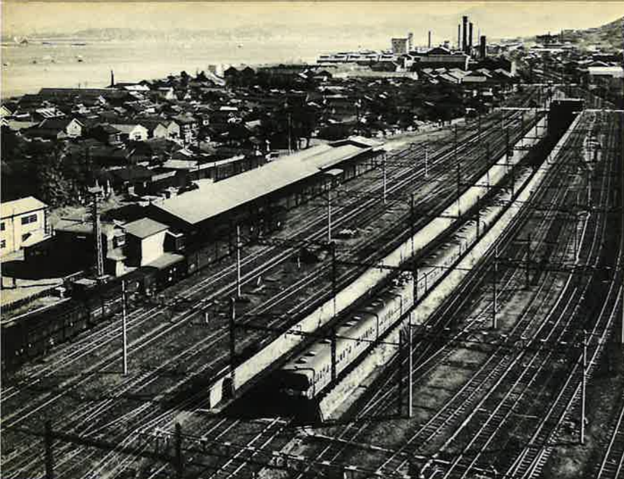
関門トンネル (門司口)
