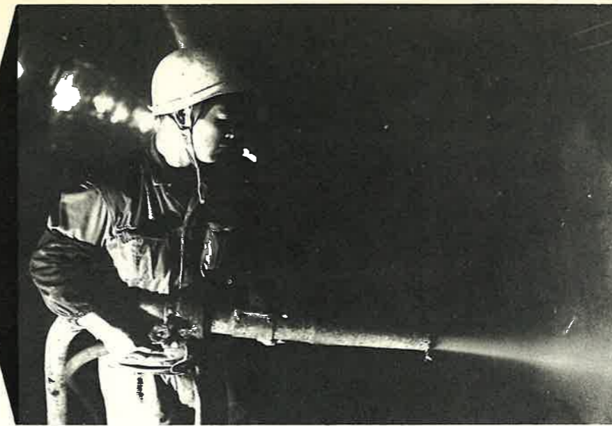
コンクリート吹付け
