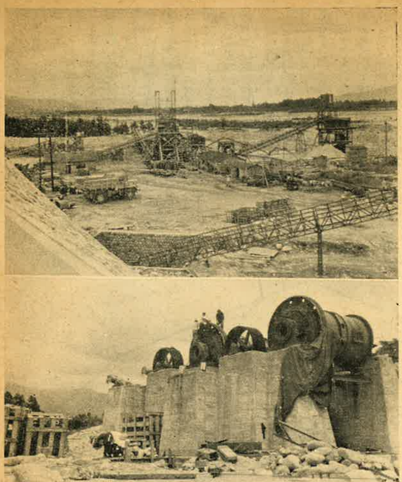
黒部の川原に建設中のクラッシングプラント
