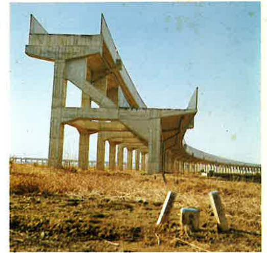
北小金高架橋
