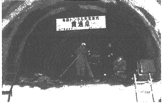
写真-2 先進導坑貫通点
