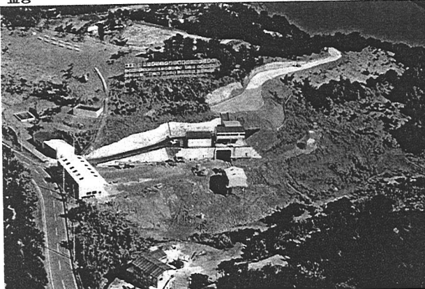
규슈 시가현에 한·일 해저터널 건설조사를 위해 설치된 작업장의 외부 모습(왼쪽)과 터널 내부. 1986년 착공한 이래 현재 폭과 높이 각각 5m 안팎 규모로 해수 밑 400m 지점까지 굴착된 상태다.
